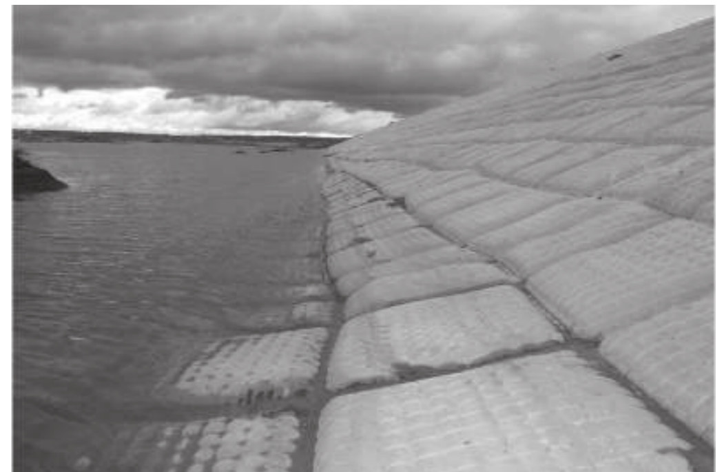
Рис. 2. Крепление откосов бетононаполняемыми текстильными матами
