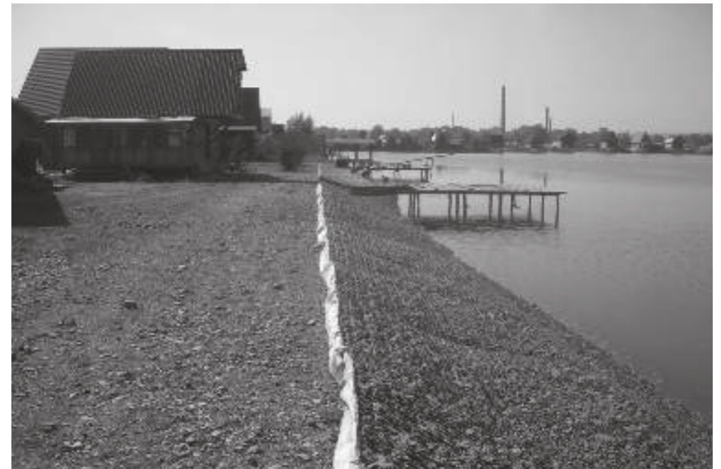
Рис. 1. Крепление откосов габионовыми матрацами
