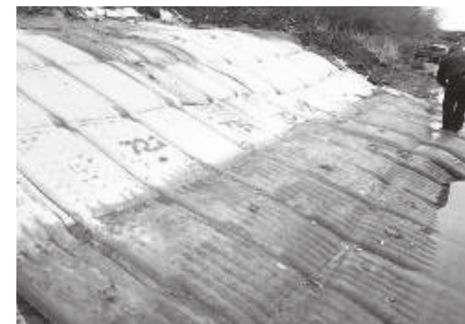
Рис. 3. Маркировка крепления краской
